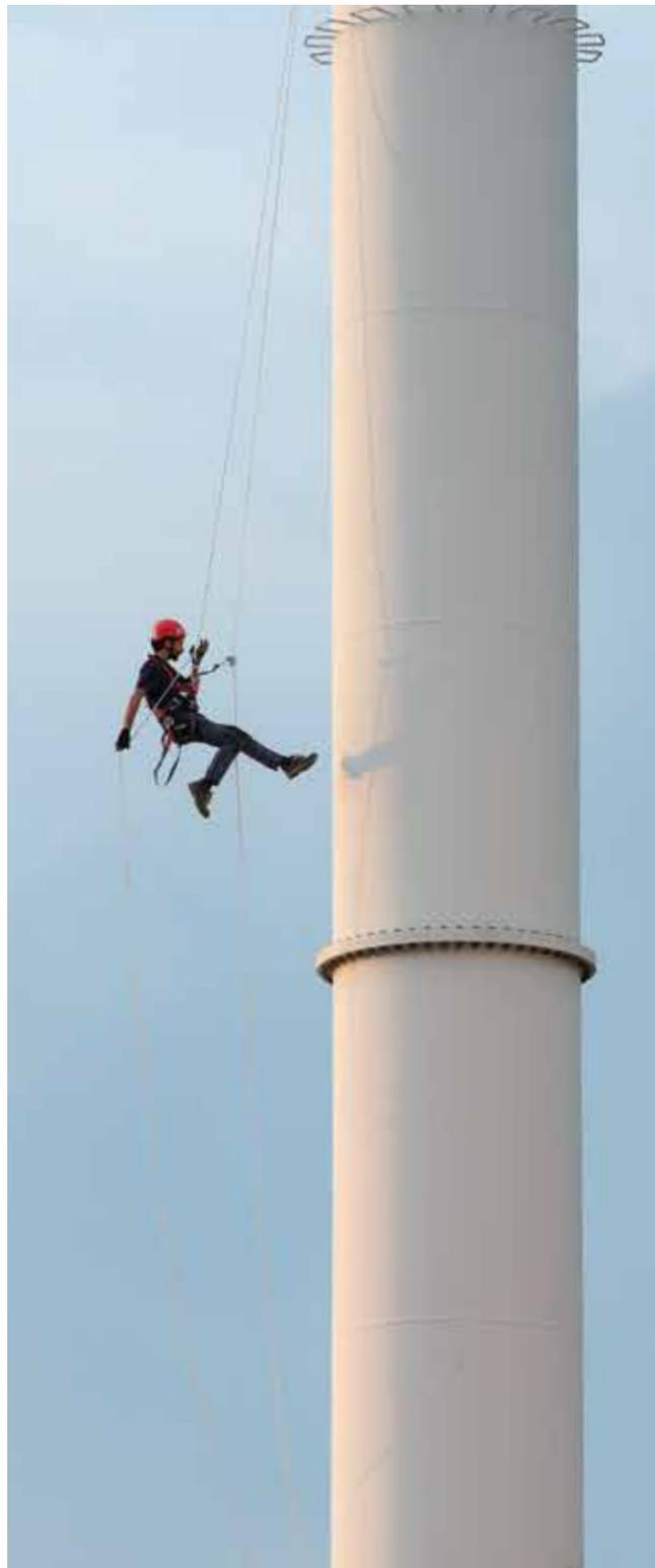
**Fig.10** - Nel caso in cui ci si trovi in sospensione con la necessità di effettuare brevi risalite, è consigliato l'utilizzo di un discensore che permetta anche la risalita abbinato ad una maniglia ed a una staffa. Questa combinazione di prodotti permette di passare agevolmente ed immediatamente dalla configurazione di discesa a quella di salita e viceversa.
